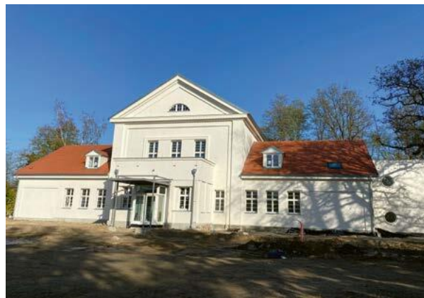
Das umgebaute Soziokulturelle Zentrum von vorne
