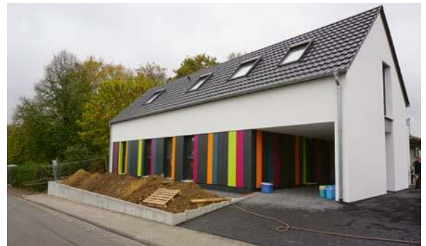
Ansicht des neuen Anbaus des Kindergartens „Vogelnest“
