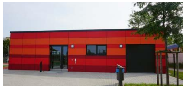
Das neue Funktionsgebäude des Sportplatzes der Hundertwasser-Grundschule
