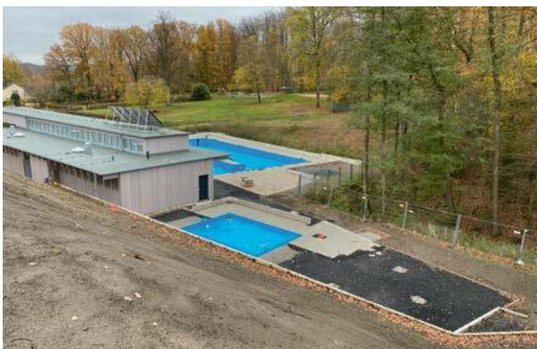
Umbauarbeiten im Waldfreibad
