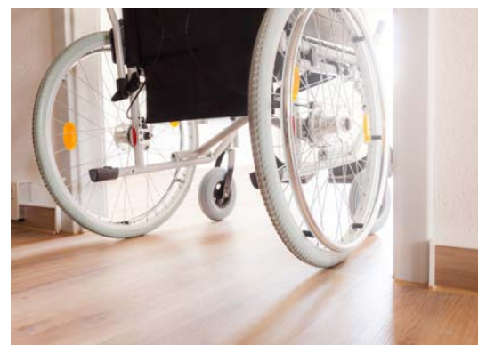
Abb. 9 Ausreichende Durchgangsbreiten, Bewegungsflächen und die Vermeidung von Schwellen und Absätzen ermöglichen die Nutzung auch mit Mobilitätshilfen.
