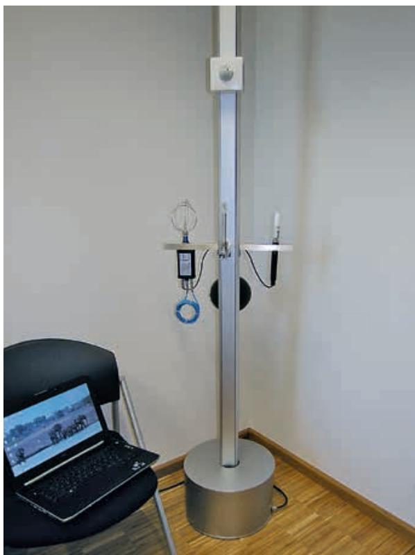
Überprüfung von Lüftungskonzepten durch CO 2 -Messungen
