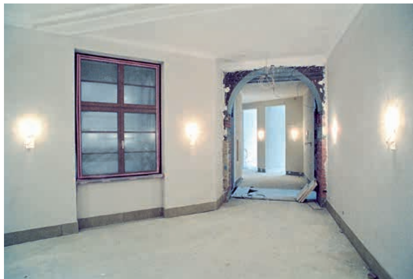
Übergang vom Alt- zum Neubau im Gebäude des BMU in der Stresemannstraße während der Baumaßnahme
