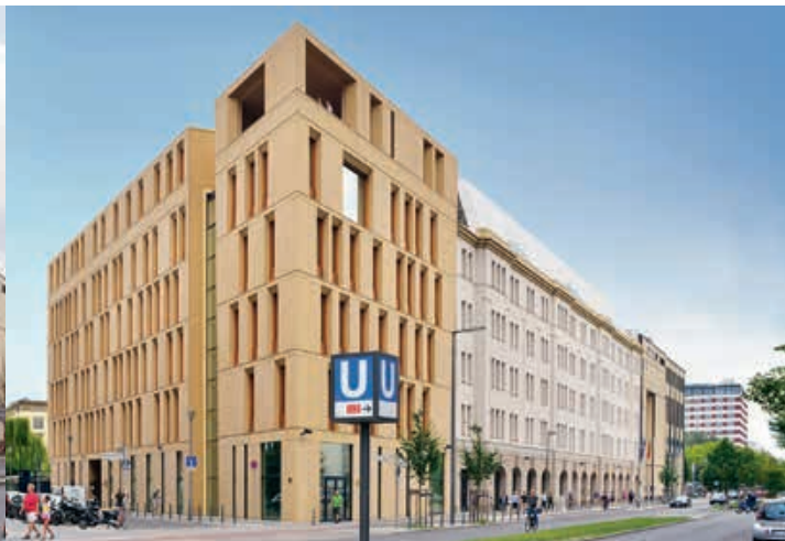
Das Bestandsgebäude Stresemannstraße 128 im Jahr 2005 (links). Heute als neues Dienstgebäude des Bundesumweltministeriums ein spannungsvolles Miteinander von Alt- und Neubau.
