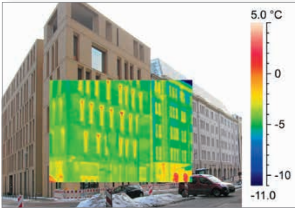
Thermografie der Straßenfassade von Alt- und Neubau des BMU in Berlin zur Überprüfung der Ausführungsqualität
