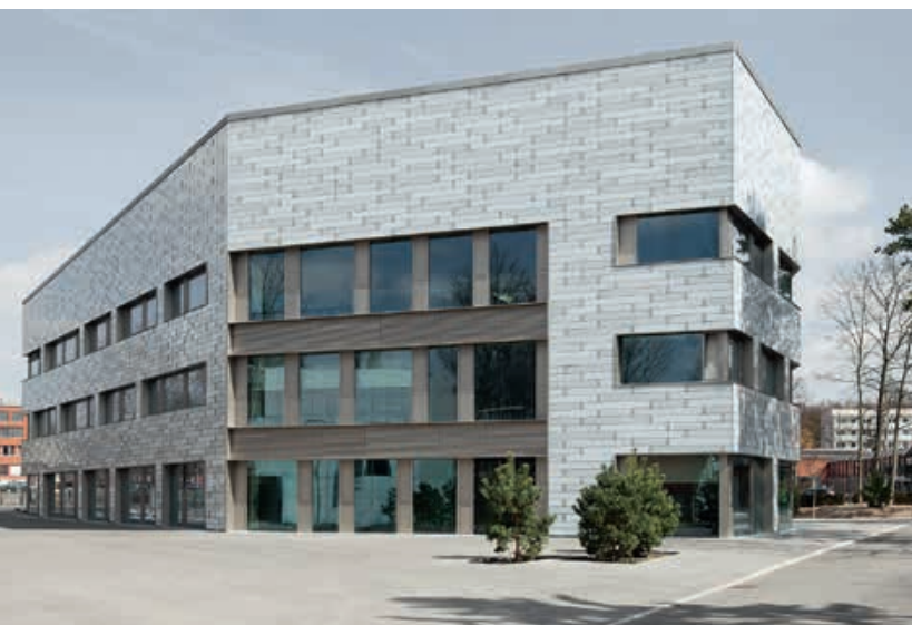
BNB-Pilotzertifizierung Forschungs- und Laborgebäude (Neubau), Experimental Research Center, Berlin
