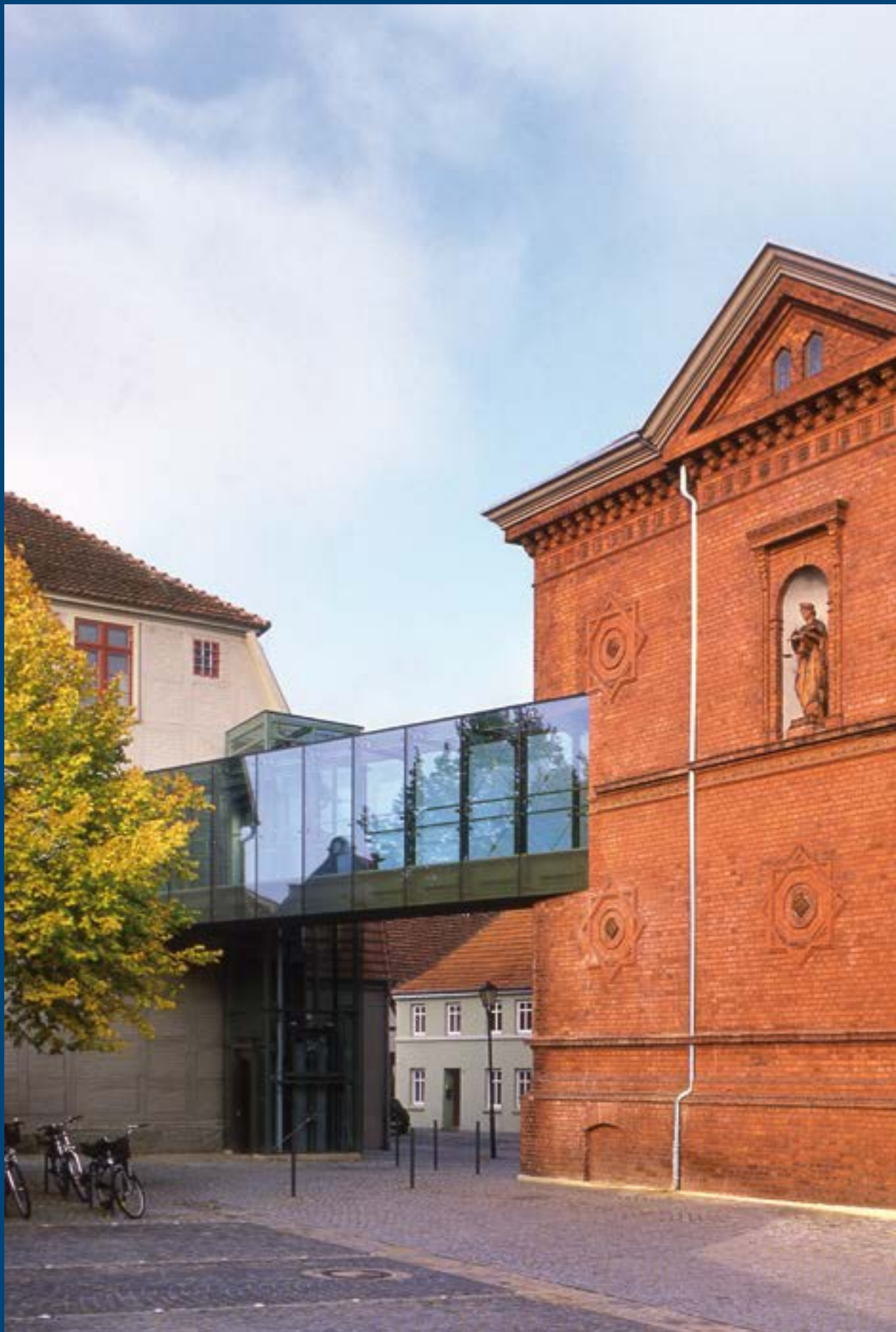
/Verwaltungssitz Malchow, barrierefreie Verbindung von denkmalgeschütztem altem Rathaus und denkmalgeschütztem ehemaligem Amtsgericht (Autzen & Reimers Architekten BDA)
