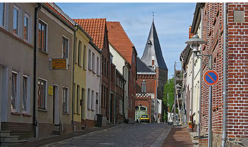
Historische Altstadt mit kleinteiliger, wertvoller Bausubstanz
