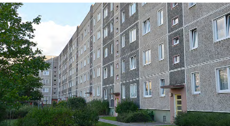
Wohnsiedlungen in Plattenbauweise mit hohem energetischen Sanierungsbedarf
