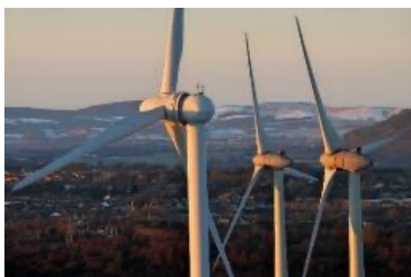
Wärme / Kälte / Strom
