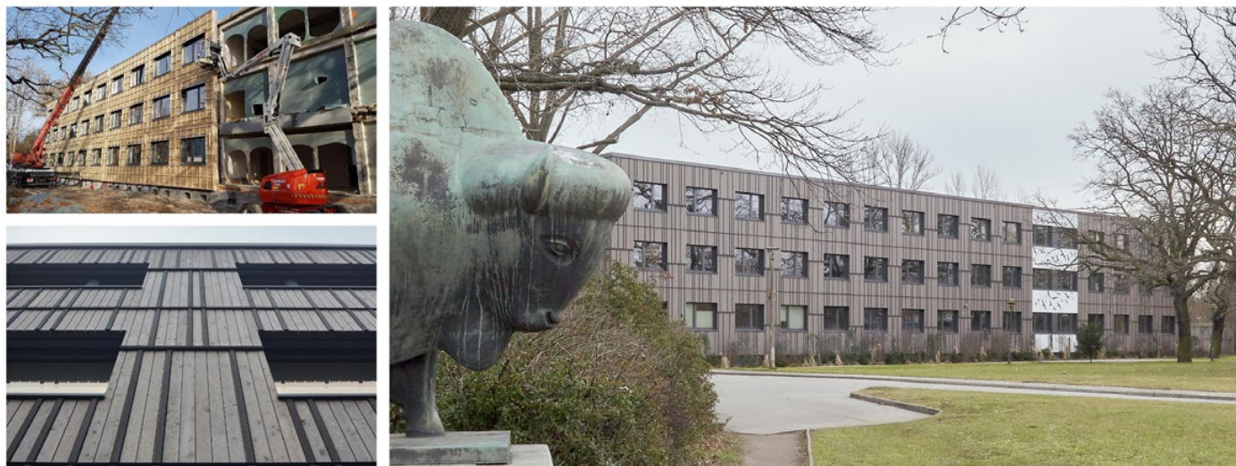
Sanierung Verwaltungsgebäude Tierpark, Kreislaufgerechte Sanierung in Holzbauweise, © ZRS Architekten Ingenieure
